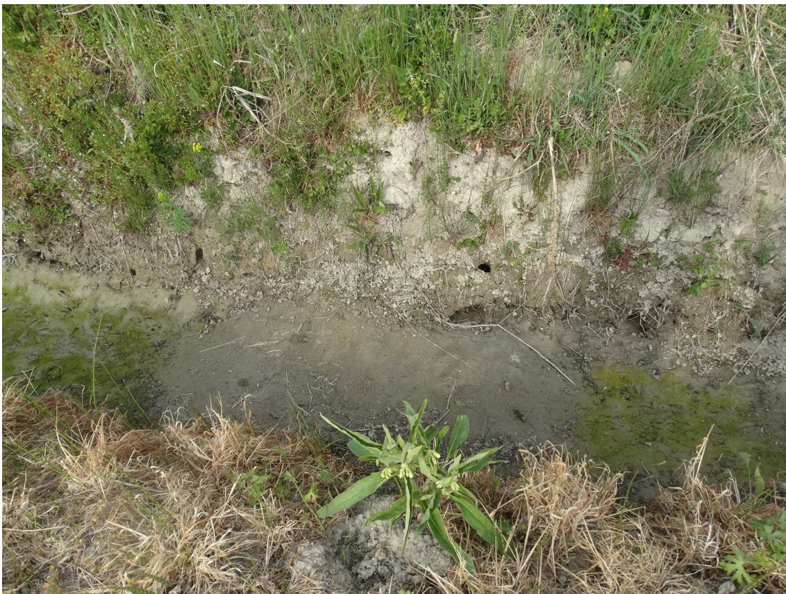
Figura 27: Piede esterno dell'argine nell'areale di intervento, con evidenti segnali di fuoriuscite di acqua.
